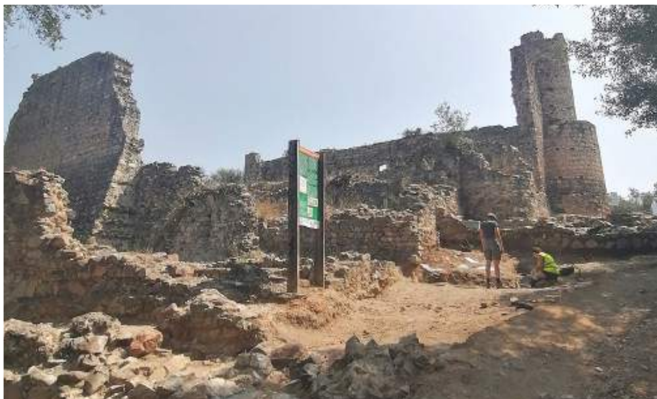
Vista general de l'excavació davant de la capella (esquerra) i de l'ampliació del castell realitzada al segle XIV (dreta).
