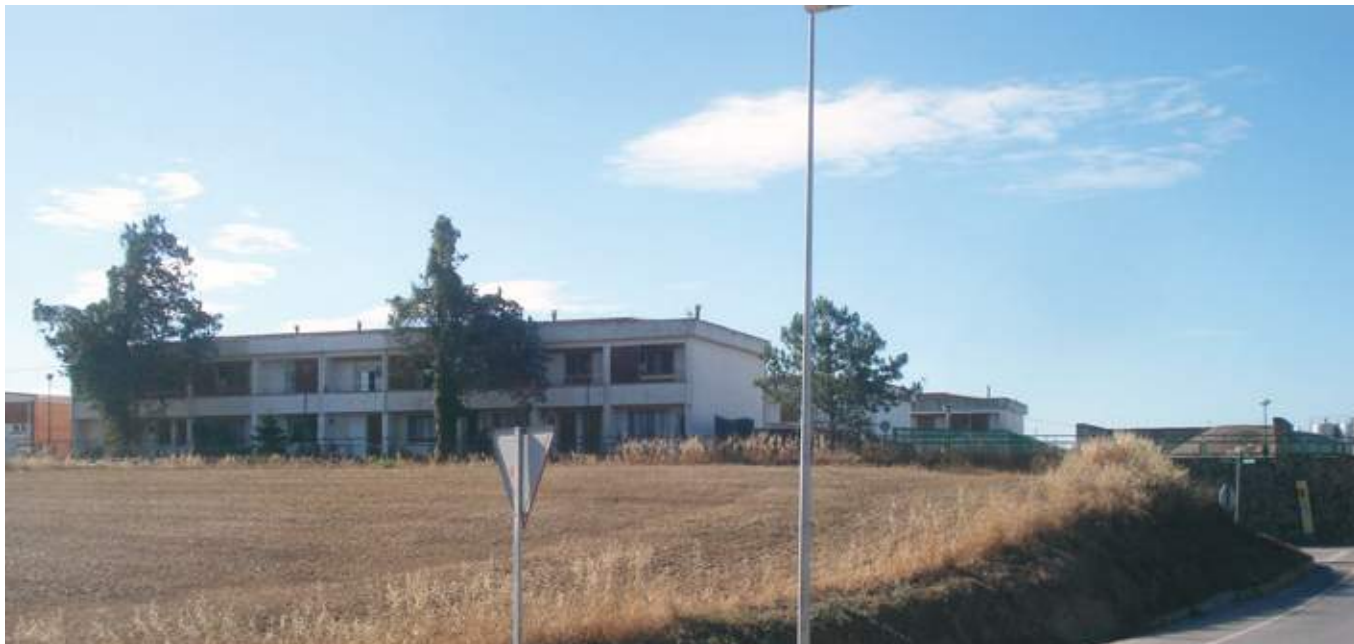
Centre de manteniment de carreteres de Vidreres el 2017. On s'observen els tres blocs d'habitatges i resta d'instal·lacions. (Josep Formiga)
