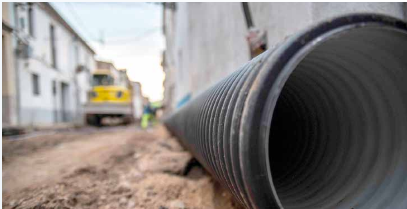
Garantir la conducció d'aigües plujanes, la prioritat d'aquesta obra.
