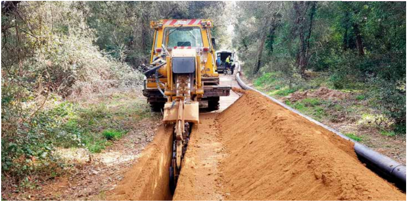
La màquina rasadora ha avançat al principi a més de 800 metres per setmana
