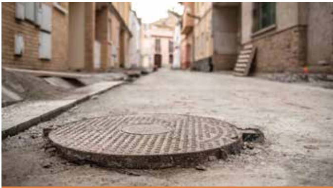
El carrer d'Orient, l'eix principal de l'obra.
