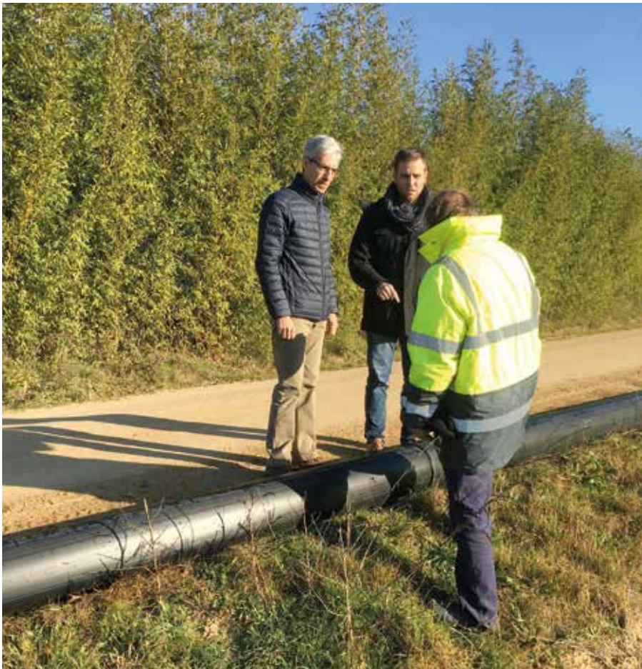
L'alcalde i el regidor, Francesc Baltrons, responsable de la comissió de municipalització del servei d'aigua, en una visita a l'obra.
