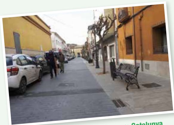
Millora del paviment dels carrers Catalunya i Pau Casals.
