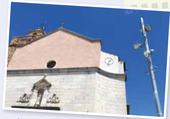
Nou enllumenat a la Plaça de l'Església.
